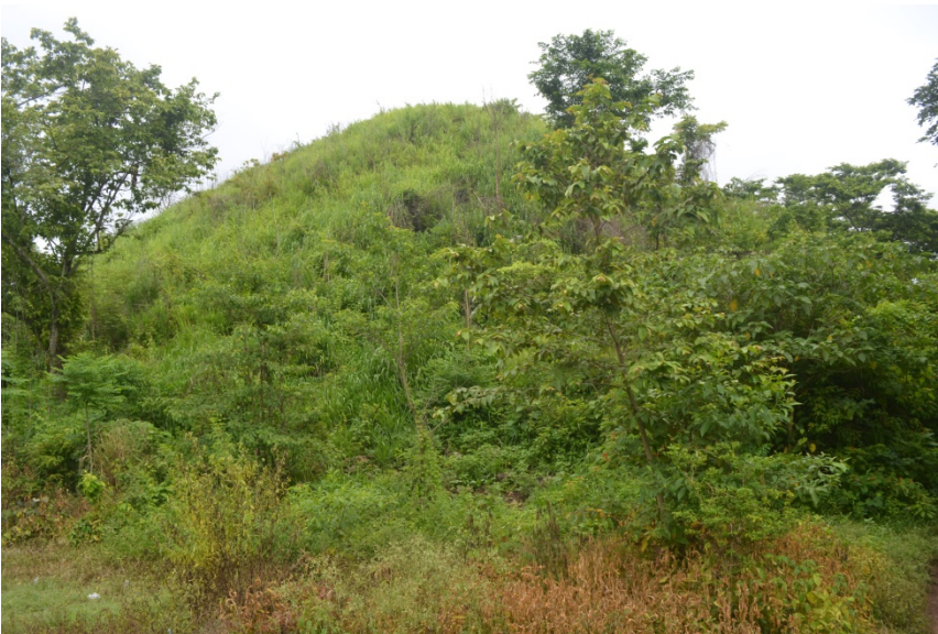
Figura 42. Estado de conservación actual de los edificios en el Grupo El Naranjo, sitio La Florida.
