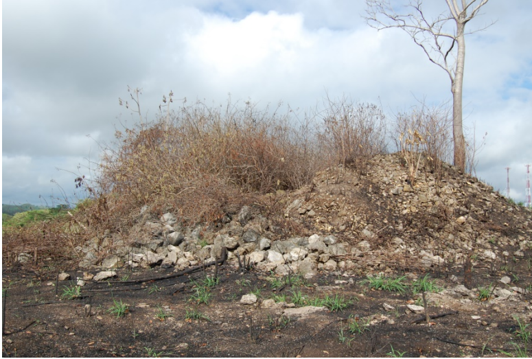
Figura 53. Estado de Conservación de los edificios en el Grupo Santa Marta, sitio La Florida.
